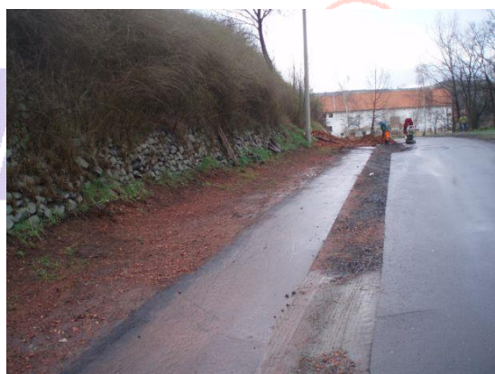
Provedení výtlačku kanalizace včetně zpětného vyspravení
