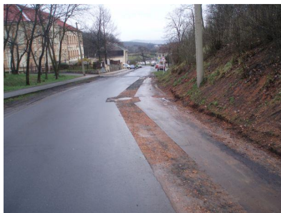
Provedení výtlačku kanalizace včetně zpětného vyspravení
