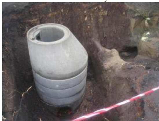
Provedení výtlačku kanalizace včetně zpětného vyspravení
