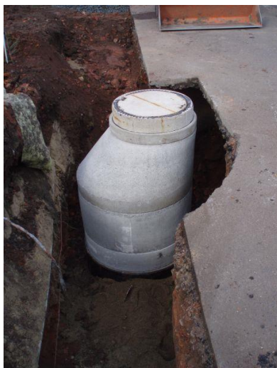
Kanalizace gravitační, ukázka osazení prefabrikovaných betonových šachet
