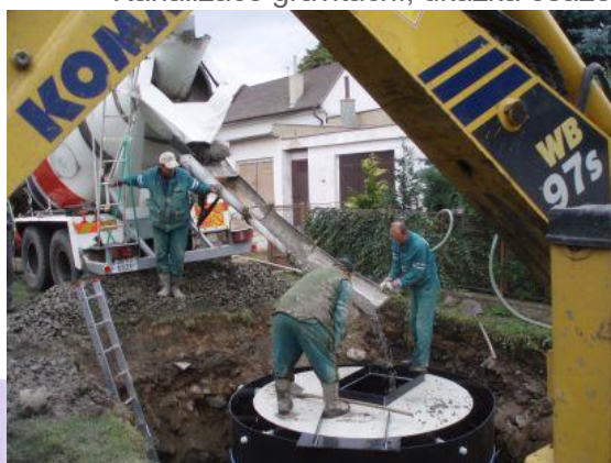
Osazení jedné ze dvou čerpacích stanic v obci včetně fotografie vnitřního vstrojení
