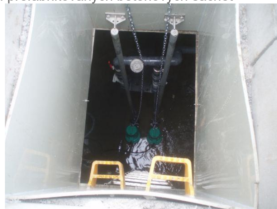
Osazení jedné ze dvou čerpacích stanic v obci včetně fotografie vnitřního vstrojení
