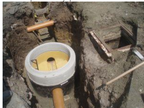
Provedení výtlačku kanalizace včetně zpětného vyspravení
